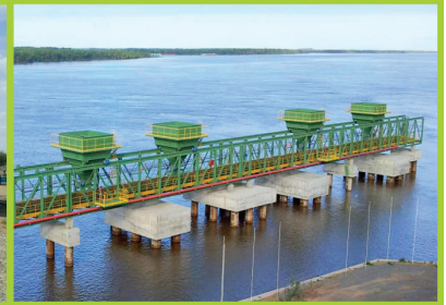
Transporte de Sólidos a Granel y Grandes Estructuras Metálicas
